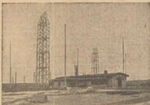
GEBOUWTJE, WAARIN K.G. TELEGRAAF-ZENDERS OPGESTELD ZIJN.
